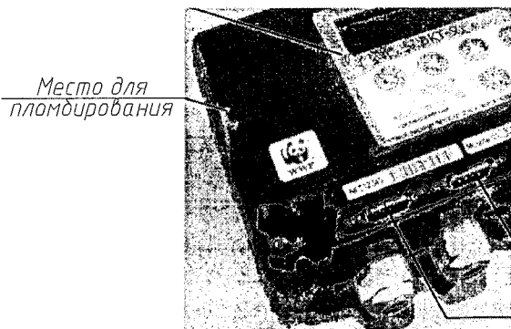
Схема пломбирования тепловычислителя
